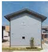
窯業系と比べ重量1/4の金属サイディングの中でも、特に軽いスターラインプライム。長尺に加工でき、しかも軽いため、1階から2階まで継ぎ目のない外壁も施工できます。
