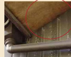
塗装ガルバリウム鋼板の腐食
