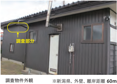
調査物件外観 ※新潟県、外壁、離岸距離 60m
