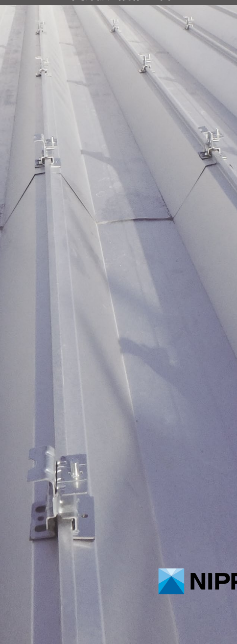
下折板 縦継ぎ部
