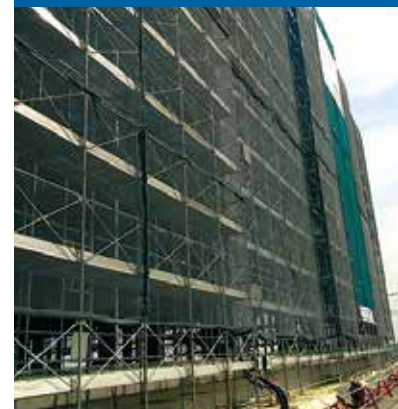
大型物流倉庫(胴縁)
